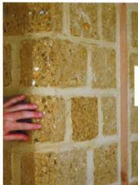
Les briques en terre crue apportent inertie et isolation acoustique performante.
